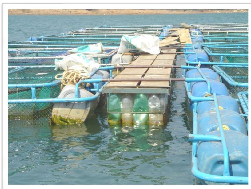
**Figura 21 - Garrafas PET empregadas como estrutura de flutuação de tanque-rede.**
