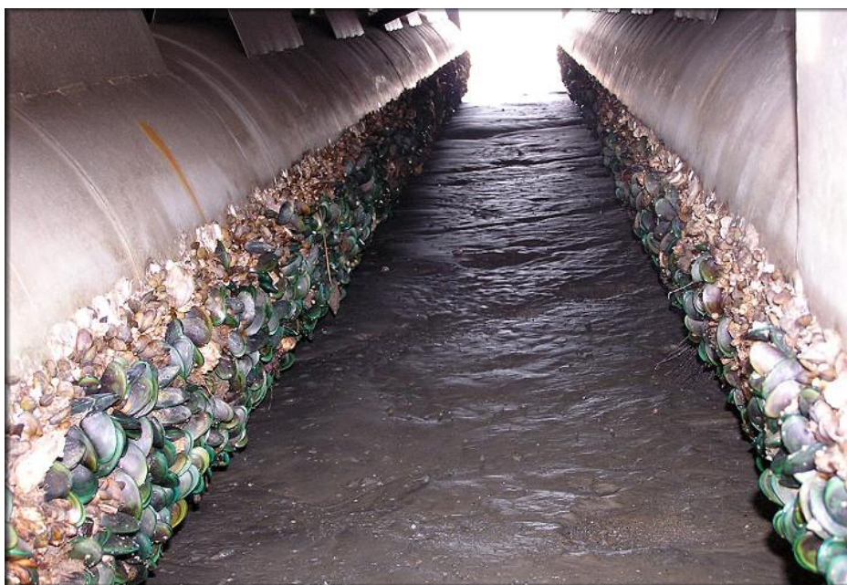
Figura 4. O crescimento do mexilhão verde, Perna viridis , nos condutos de esfriamento de usinas termoeletricas, ocasionando perdas economicas consideraveis, por paradas frequentes e maiores custos de manutencao.
