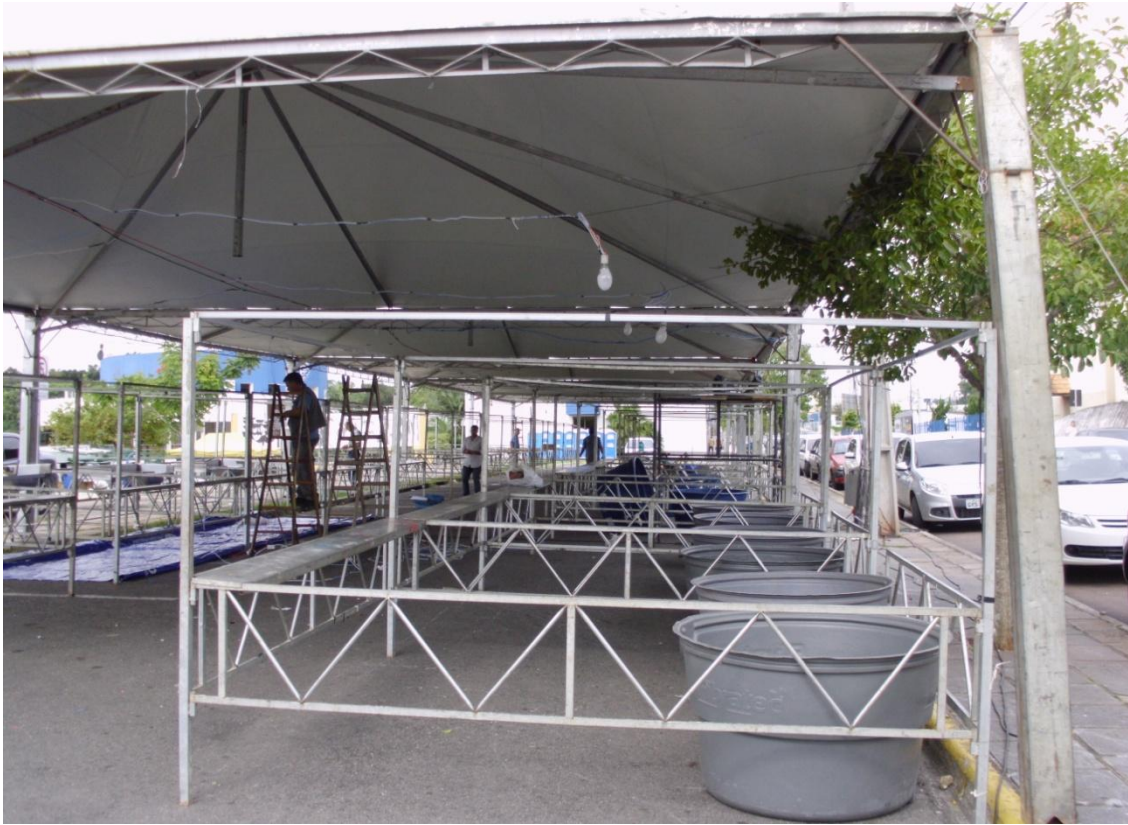
Figura 4. Montagem da estrutura para Feira do Peixe Vivo. Foto cedida pela SEAB – SJP, 2012
