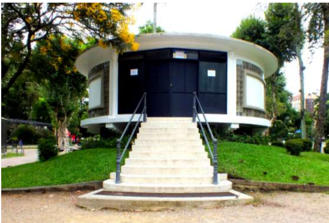
Figura 5. Construção reservada ao aquário. Fonte: Juliana Pucca.
