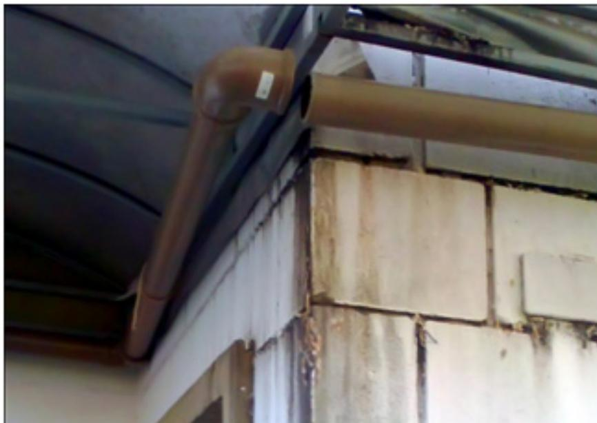
Figura 10 - Rompimento do cano de aeração devido ao aquecimento e dilatação do mesmo.
